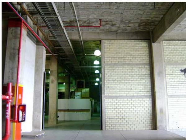
Figura A-2. Tipo estructural con columnas y traves de concreto reforzado
