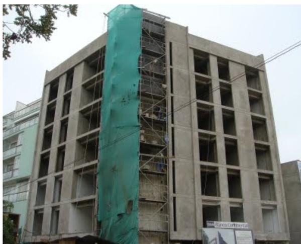
Figura A-3. Tipo estructural con columnas, traves y muros de concreto reforzado
