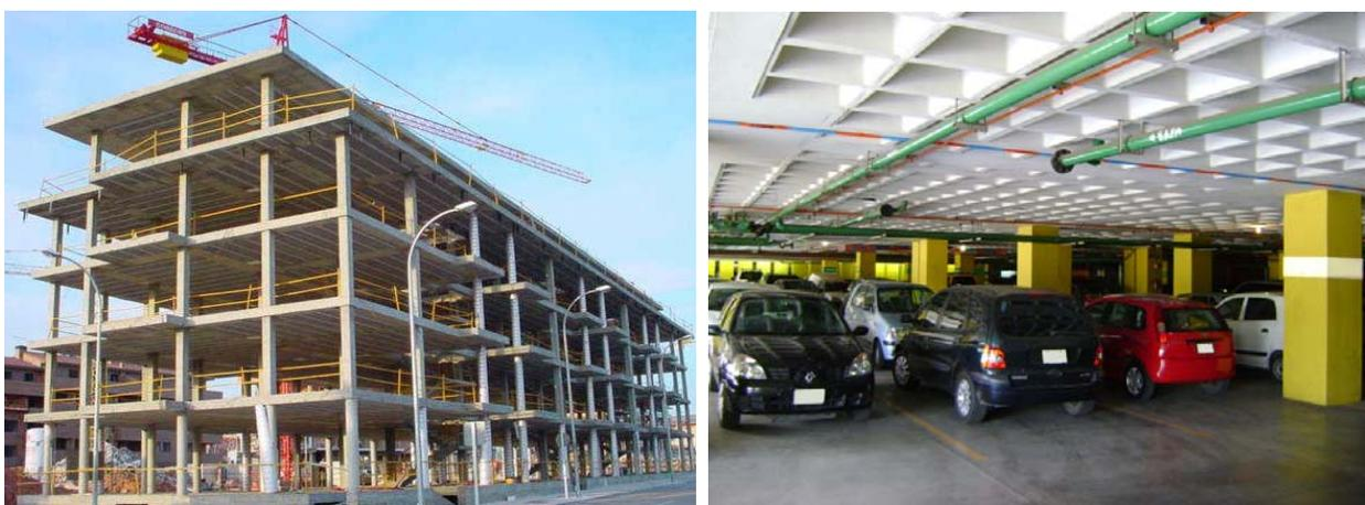
Figura A-8. Losas planas de concreto con columnas de concreto: Izq. losa plana y Der. losa reticular
