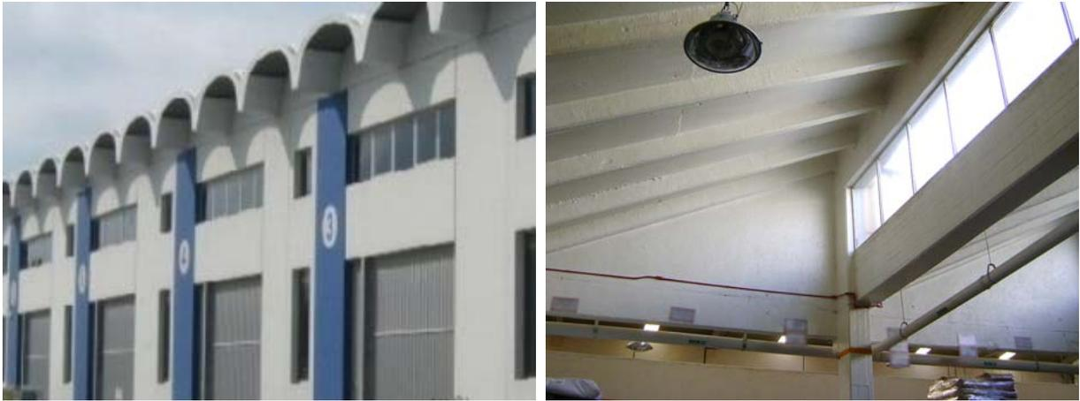
Figura A-11. Industriales de cubierta pesada: Izq. no rigidizada y Der. rigidizada
