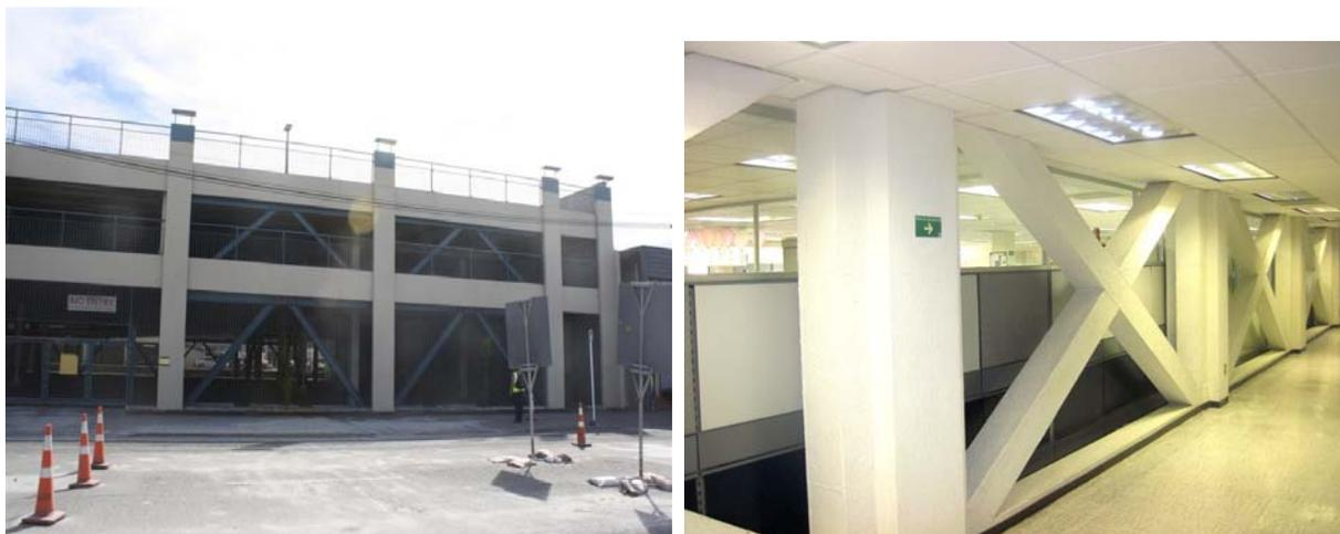
Figura A-4. Columnas y traves de concreto con contraventeo: Izq. diagonales en el exterior y Der. diagonales en el interior
