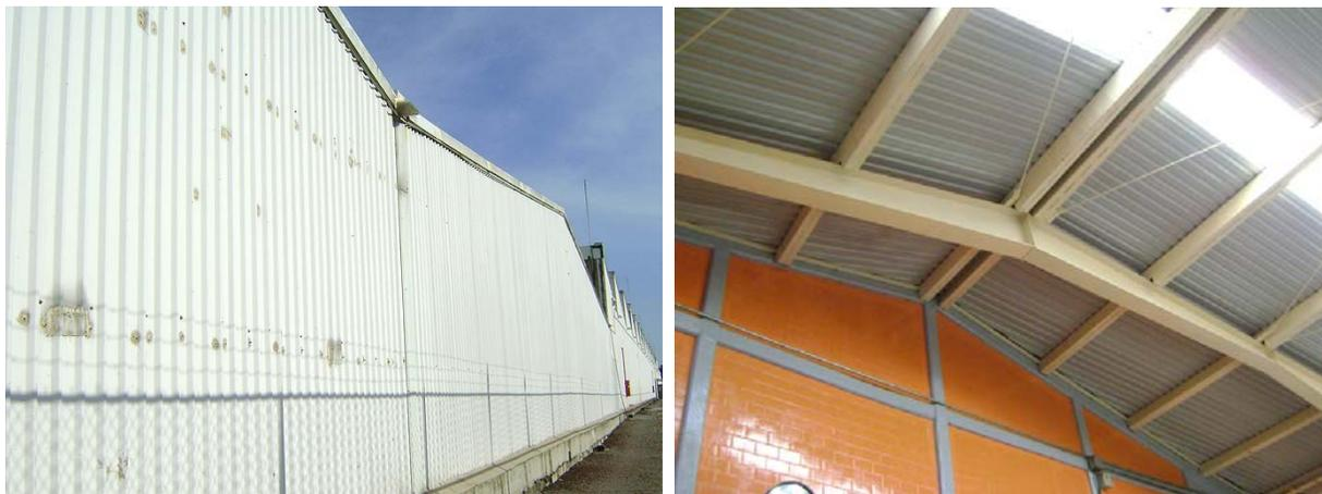
Figura A-10. Industriales de cubierta ligera: Izq. no rigidizada y Der. rigidizada
