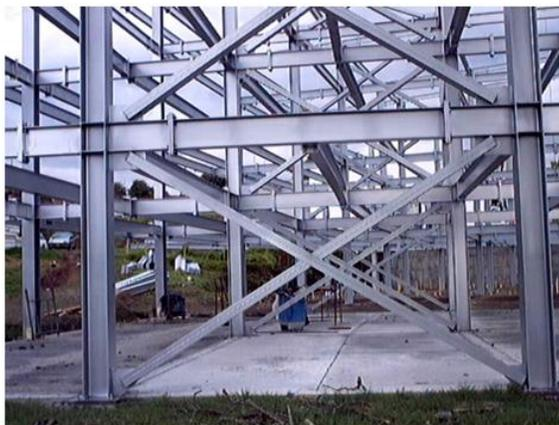
Figura A-6. Columnas y traves de acero estructural con diagonales de acero
